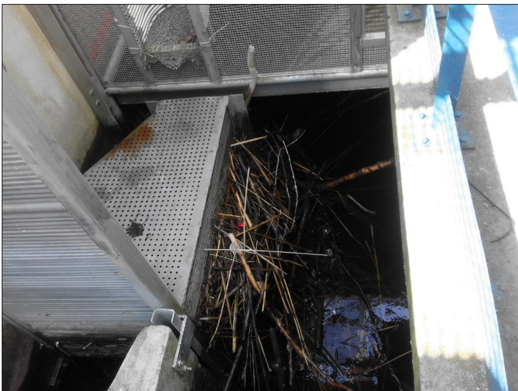
Fot 3,4. Nieczystości zgromadzone na koszu w komorze nr 60, przyniesione z wodą roztopową (18 kwietnia 2018).
