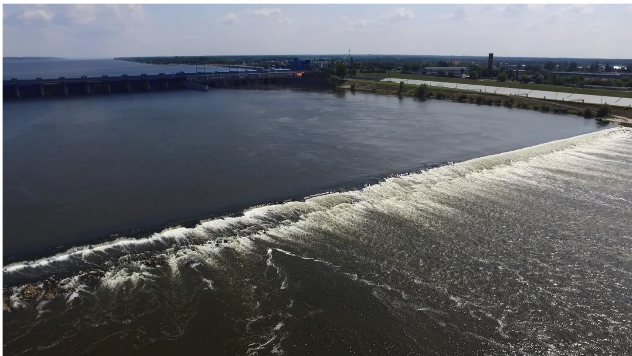
Fot nr 12. Widok progu stabilizującego od strony wody dolnej przy przepływie około 450 \text{ m}^3/\text{s} widoczny układ strug wody i różnica piętrzeń (zdjęcie z dronu – Zarząd Zlewni Włocławek).
