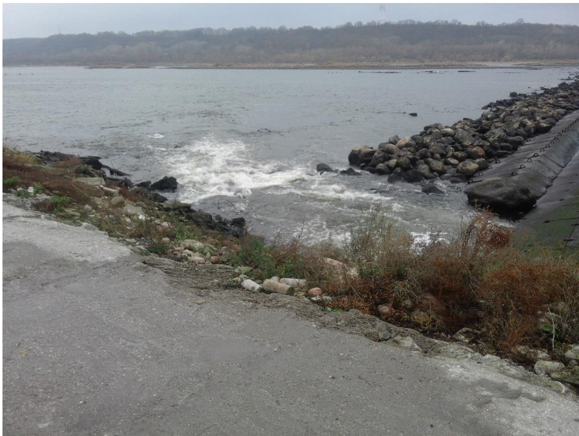
Fot. nr 13 - lewy przyczółek progu stabilizującego na styku z kierownicą awanportu dolnego podczas wstrzymania przepływu w dniu 14 listopada 2018. W tym miejscu znajdują się wyloty rur odwadniających basen dolnego stanowiska Stopnia. Widoczny wypływ wody.
