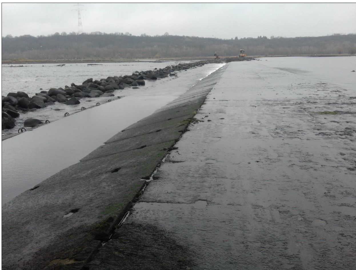
Fot. nr 11 – perspektywa progu od lewego brzegu w osi części czołowej, podczas procedury wstrzymania przepływu przez Stopień ( 14 listopada 2018). Widoczna różnica poziomów pomiędzy W progową i rzeki.
